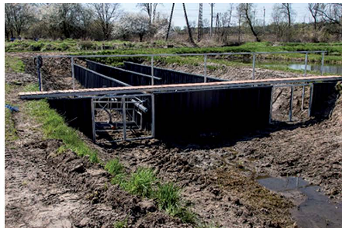
Rys. 3. Modernizacja i adaptacja niewielkich stawów ziemnych na potrzeby tuczu okonia.
